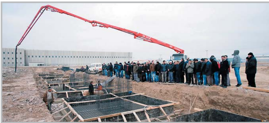
Укладка первого куба бетона в основание будущей фабрики
