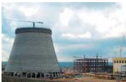
Строительство Нововоронежской АЭС-2
