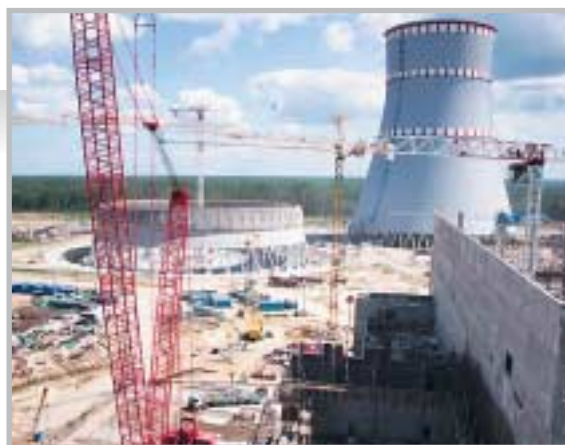
Строительство Ленинградской АЭС-2
