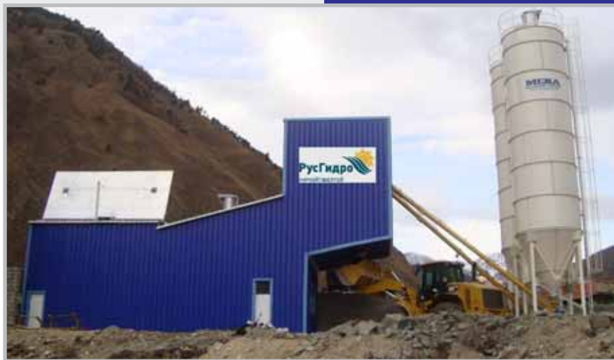
МЕКАМІХ-60-М на строительстве Зарамагских ГЭС в Северной Осетии
