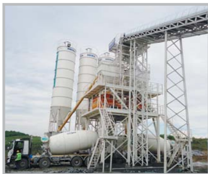
Бетонные заводы МЕКА на стойтельной площадке Стамбульского аэропорта работают практически в круглосуточном режиме
